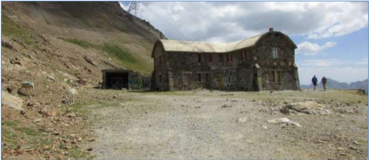
Photo n° 47 : Bâti hôtellerie des Laquets
