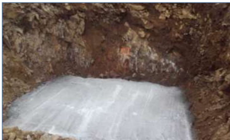
Photo n° 3 : Exemple d'une béton de propreté en fond de fouille
