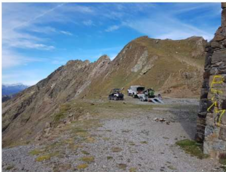
Figure 2 - Photographie de la plateforme support de la future extension - 06/09/2022
