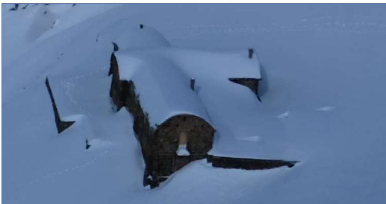
Photo n° 5 : Accumulation de neige sur l'hôtellerie
