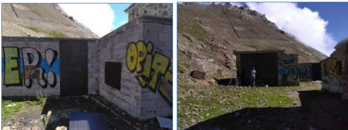
Photo n° 51 : Calfeutrage des entrées du bâtiment
