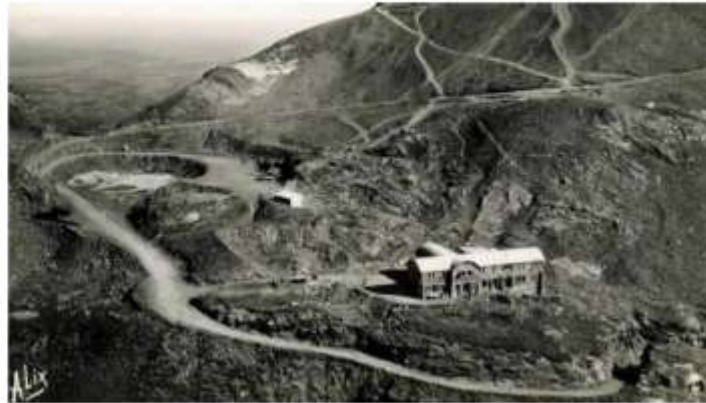
Figure 10 - Photographie d'époque non datée montrant une configuration moins avancée de la plateforme
