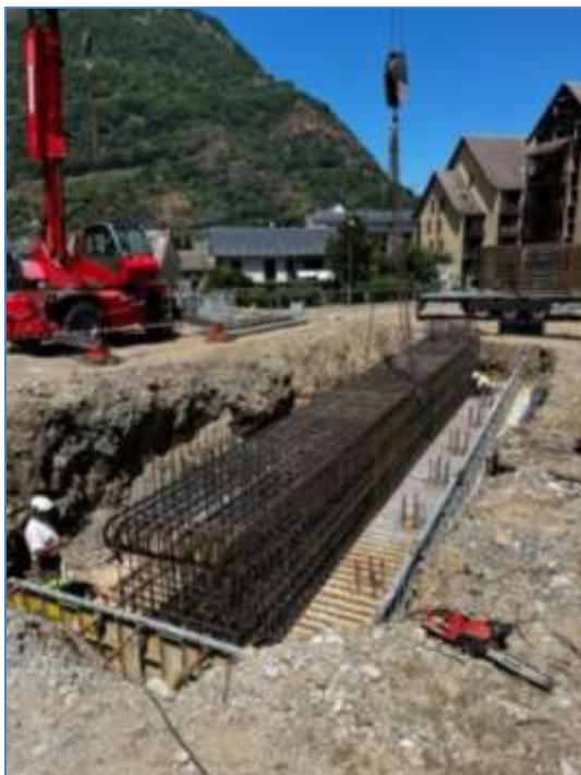
Photo n° 4 : Exemple d'une semelle en cours de ferrailage et de coffrage
